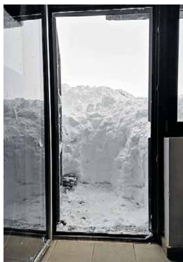
Una de las entradas al refugio. dv
